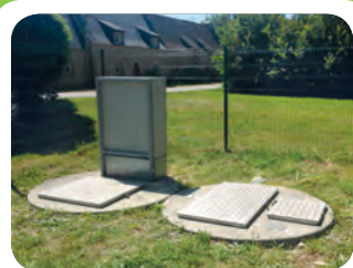
Poste de relèvement des eaux usées
