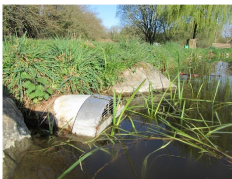
Aménagement d'une grille sur le trop plein de l'étang communal de Lauzach_
